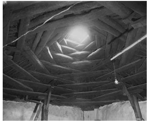
Перекрытия традиционного жилища, село Мартуни (Гехаркуник). Вторая половина XIX в. Фото из личного архива А. Марутяна
